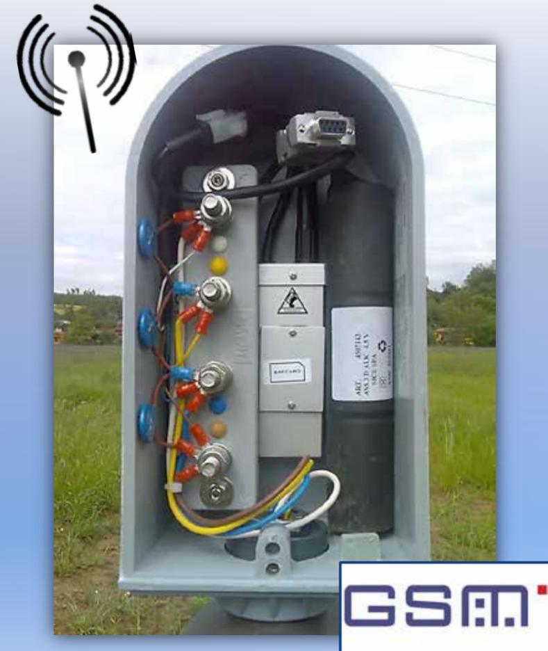
Mod. TDA3: unità di telemisura a palina con tecnologia GSM.
